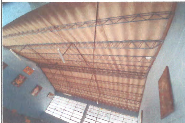
Foto 3: Mejoramiento de sistema electrico interior y exterior
