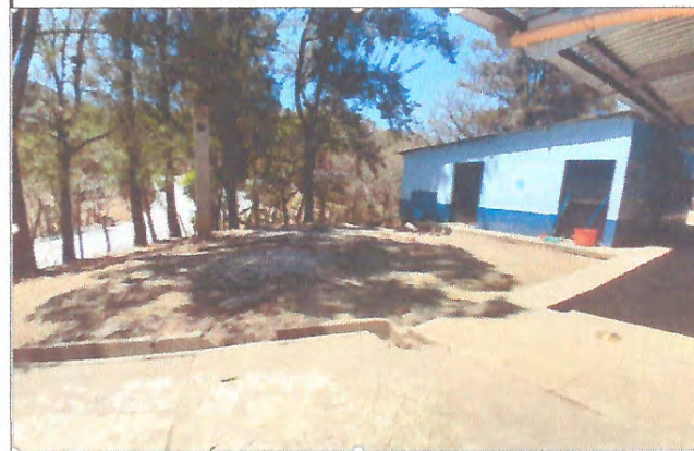
Foto 4: Mejoramiento con estructura tipo portico y lamina troquelada calibre 26 para cocina.
